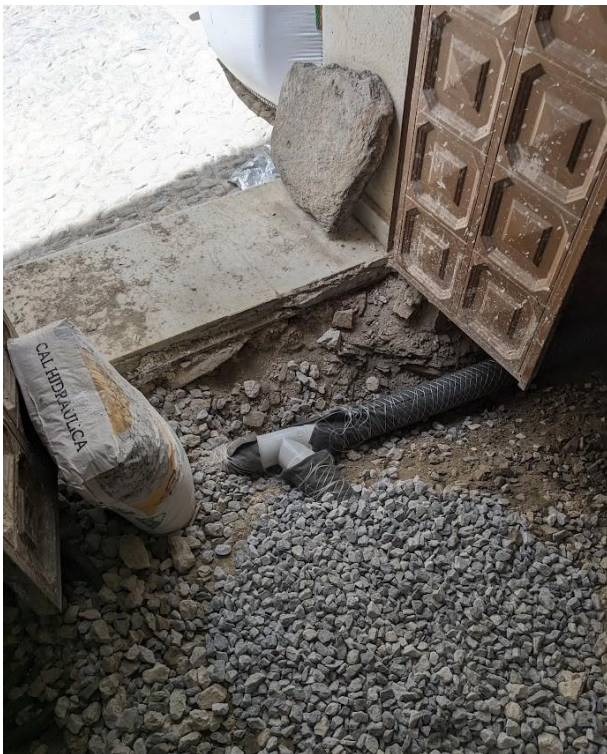
Proceso de ejecución del caño seco con tubo de drenaje y remate en cubierta
