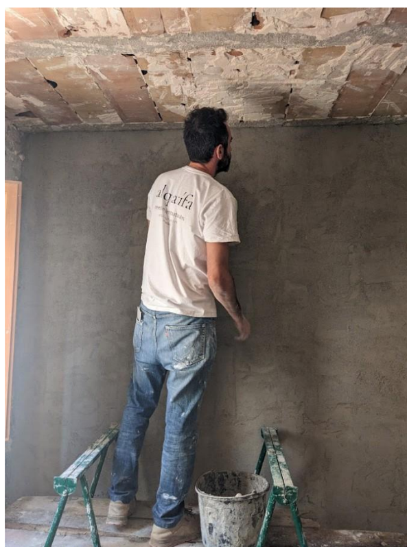
Aplicación de revestimiento de cal en paramentos verticales
