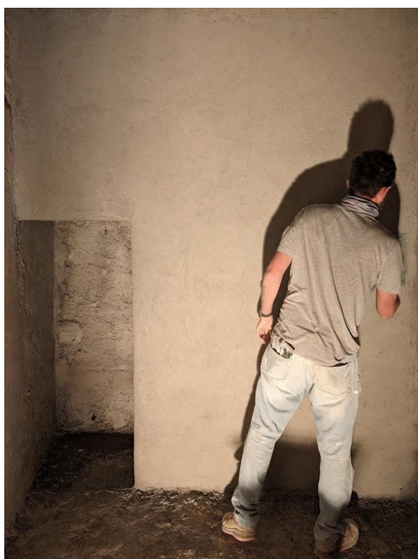
Aplicación de revestimiento de cal en paramentos verticales
